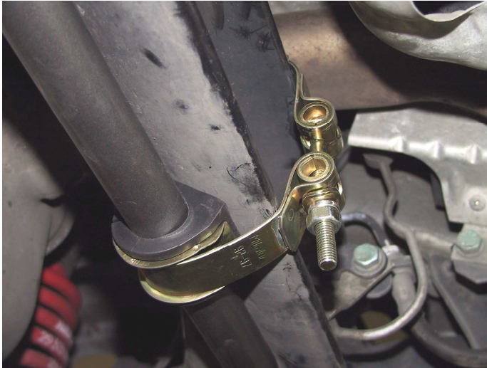
Abbildung/figure 1: Anbau der Schelle /fitment of the clamps
